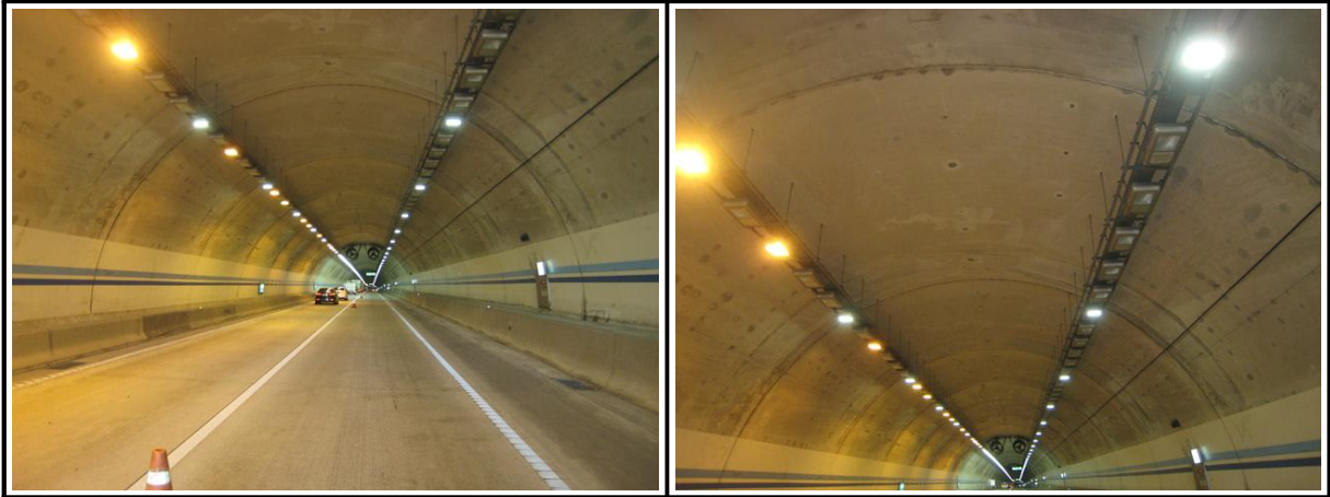
【사진 1.3.14】 라이닝 천단부 전경
