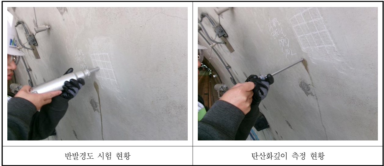
【사진 1.4.1】 콘크리트 내구성조사 현황
