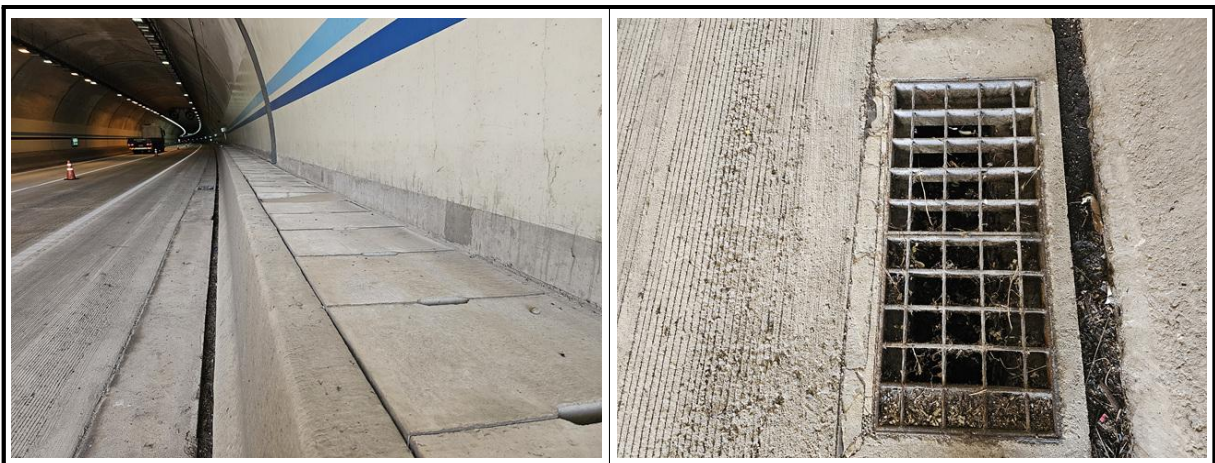
【사진 1.3.8】 공동구 및 배수시설 전경
