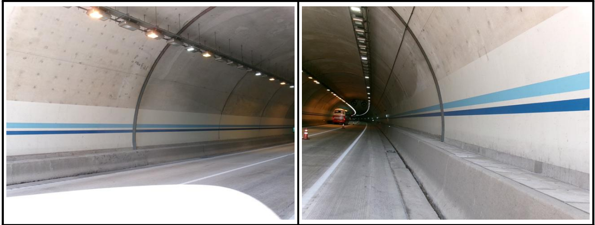
【사진 1.3.3】 라이닝 측벽부 전경
