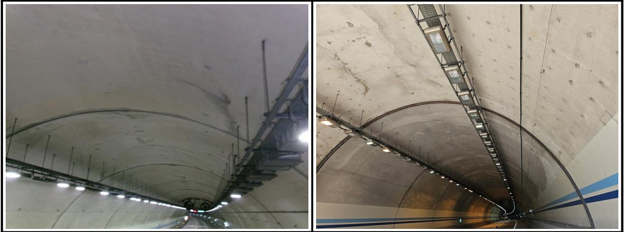
【사진 1.3.1】 라이닝 천단부 전경
