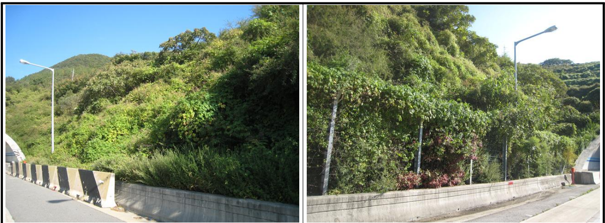
【사진 1.3.7】 사면 전경
