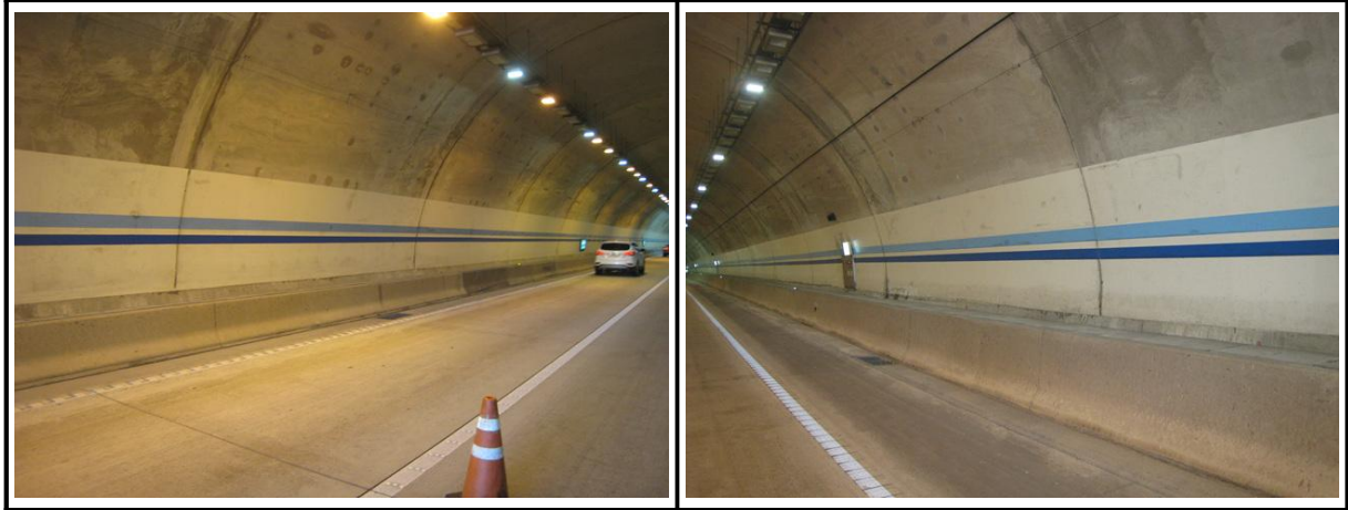
【사진 1.3.16】 라이닝 측벽부 전경
