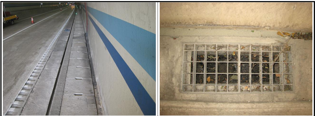
【사진 1.3.21】 공동구 및 배수시설 전경
